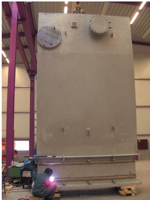
Aufschweißen eines Rechteckkompensators Welding of a rectangular expansion joint
